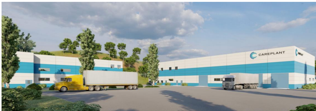
Рис. 3. Проект ООО «Полимет Инжиниринг» «CAREPLANT. Цинковый завод нового поколения» г. Верхний Уфалей
